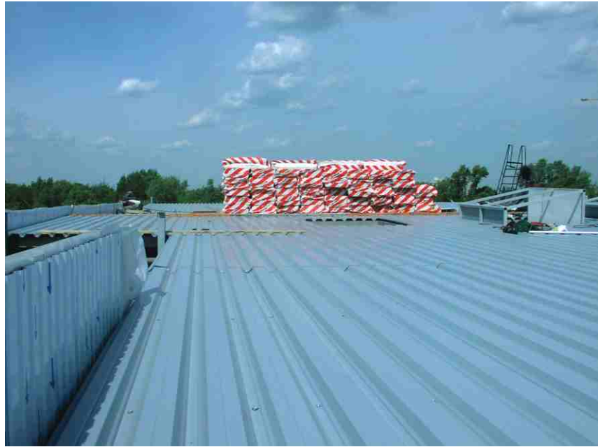
Монтаж кровли на СТО "Nissan", г. Киев
