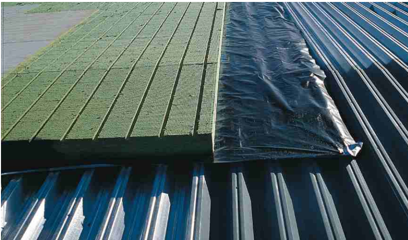
Революционная система PAROC Air в процессе монтажа
